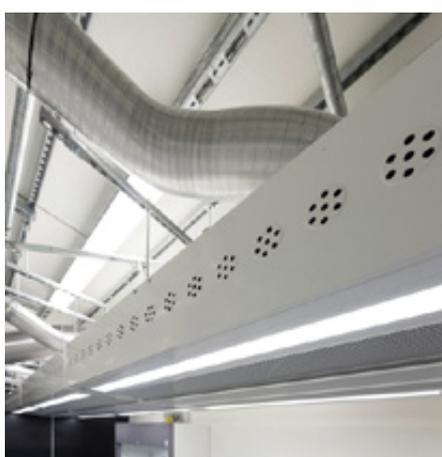
Einstellbare Auslässe an den Längsseiten ermöglichen eine sichere Verdünnungslüftung auch bei sehr geringen Luftvolumenströmen von nur 25 Kubikmetern pro Stunde und Quadratmeter Laborgrundfläche [ $\text{m}^3/\text{hm}^2$ ]. (Bildrecht: Jörg Stanzick)
