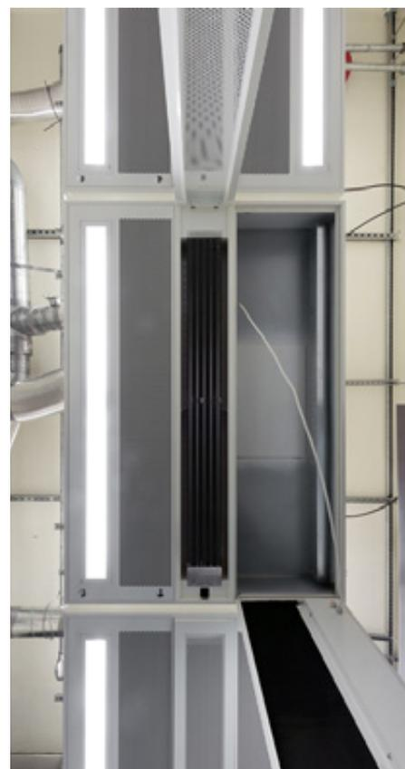
Für Wartungsarbeiten oder zum Reinigen und Desinfizieren lassen sich die Module einfach und ohne Werkzeug großflächig öffnen. Mittig erkennbar ist der optionale Wärmetauscher. (Bildrecht: Jörg Stanzick)
