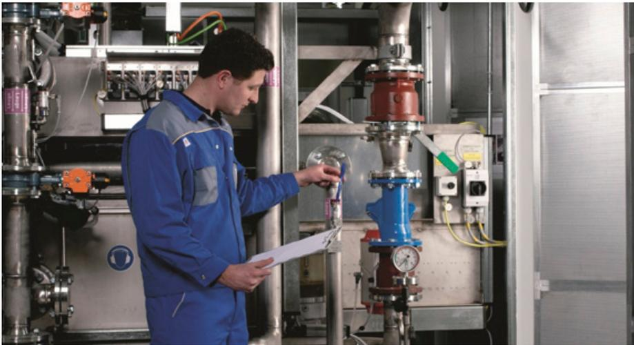
Kundenspezifisch festgelegte Wartungsintervalle ermöglichen den „kontrollierten Produktionsausfall“ mit verringerter Anlagenstillstandszeit und ohne unkontrollierbare Kosten. (Foto: Dürr Ecoclean)
