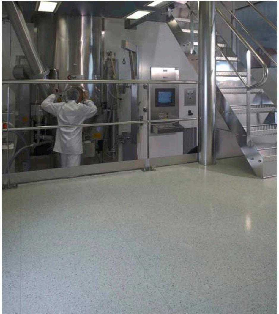
TROL sowie die Unversehrtheit des gesamten Bodens zu testen. Das Prüfsystem zeigt mittels Lichtbogen und akustischem Warnsignal Undichtigkeiten auf. Dieses Prüfverfahren eignet sich nicht nur bei der Neuverlegung des Bodens, sondern auch für regelmäßige Kontrolluntersuchungen. Eventuelle Beschädigungen und Undichtigkeiten können sofort und ohne Behinderung der Produktion beseitigt werden.
