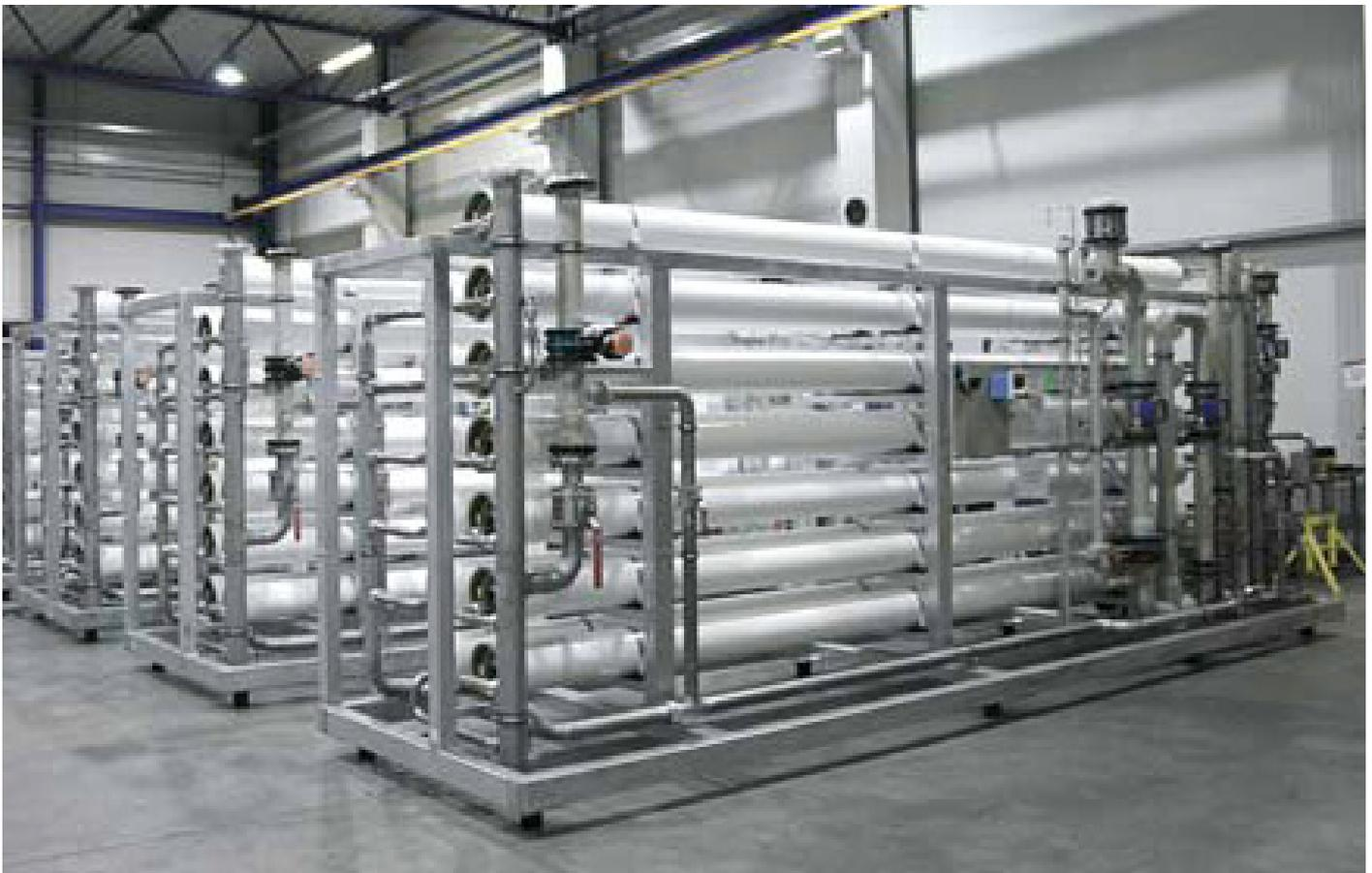
Das Herzstück der UPW-Anlage bildet eine permeatgestufte Umkehrosmose-Anlage. Die dreistraßige Anlage stellt 3 x 50 % Redundanz sicher. (Foto: Hager + Elsässer)
