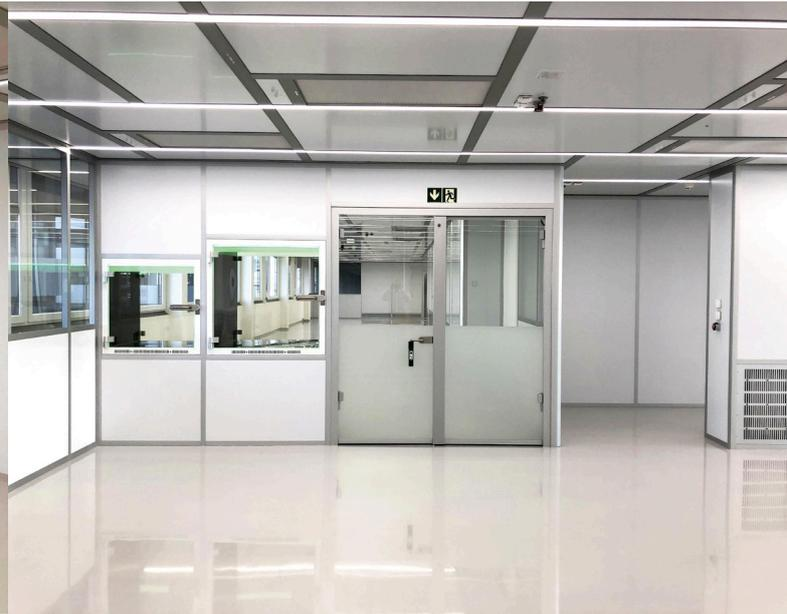
Über mehrere farblich visualisierte Materialschleusen werden die Implantate sicher von der Reinraumzone ISO7 in die Reinraumzone ISO 8 transportiert.
