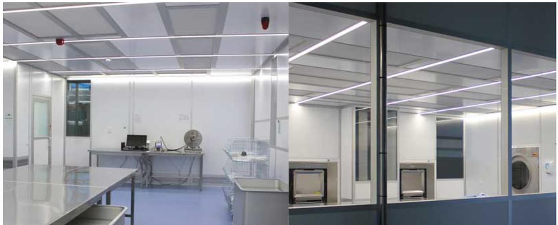
Reinraumsystem CleanCell4.0® der ISO-Reinraumklasse 5. Die dimmbare LED Beleuchtung sorgt für ausgewogenes Licht im Bereich des Legetisches.
