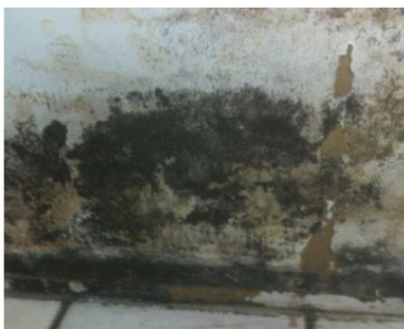
Bild 1: Wand mit Wasserschäden und Schimmelbefall (Foto: Jim Polarine)
