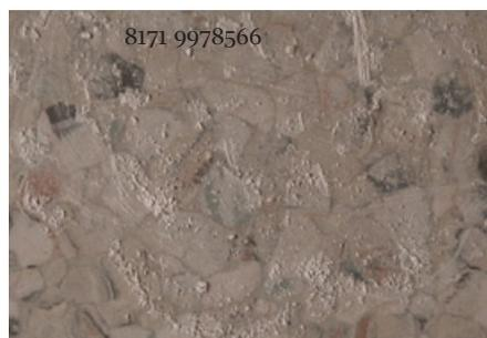
Bild 4 (Desinfektionsmittelrückstände auf Vinylboden)
