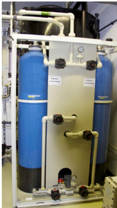
Ionentauscheranlage zur Reinraumwasserversorgung an der FH Kaiserslautern/Standort Zweibrücken (Photo: W. Pfeifer)
