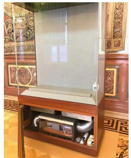
CityCarb und MiniClima-Gerät in einer Vitrine. (Bild: Camfil)
