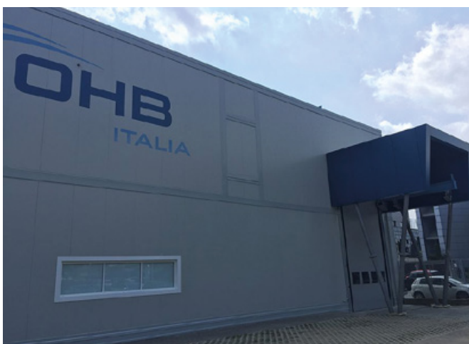
Die Außenansicht der neuen Produktionshalle. (© OHB SE)
