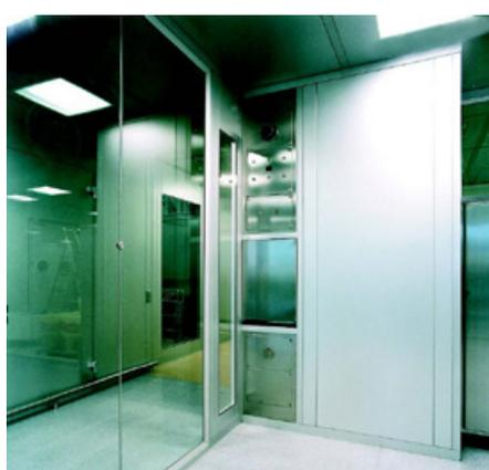
GMP Wandsystem aus Aluminium mit Versorgungspunkten
