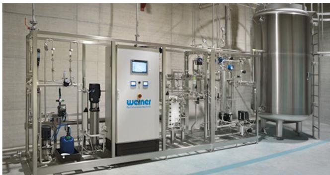
Werner WFI-Anlage 600 l/h: Kalte WFI-Erzeugung mit Härtestabilisator und 5.000 l - Lagertank (© Werner GmbH 2018)
