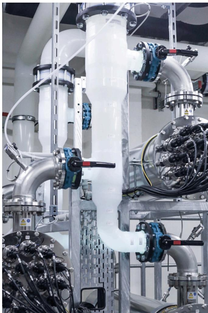
Die Reinstwasser-UV-Anlage zur TOC-Reduktion und Entkeimung.
