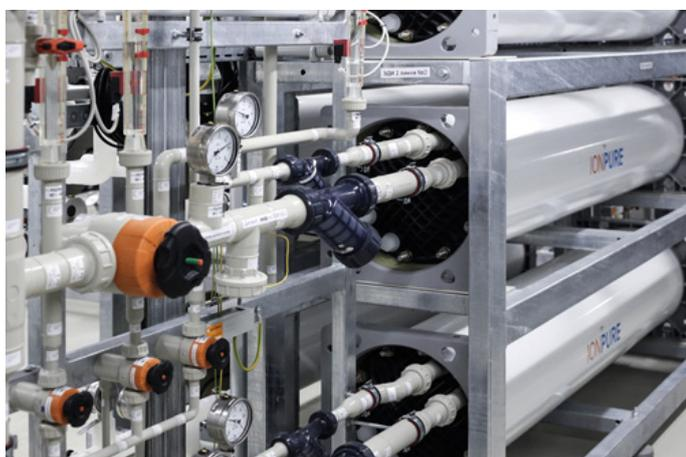
Die Erzeugung des Reinstwassers erfolgt durch eine Kombination aus Umkehrosmose und Elektrodeionisation.
