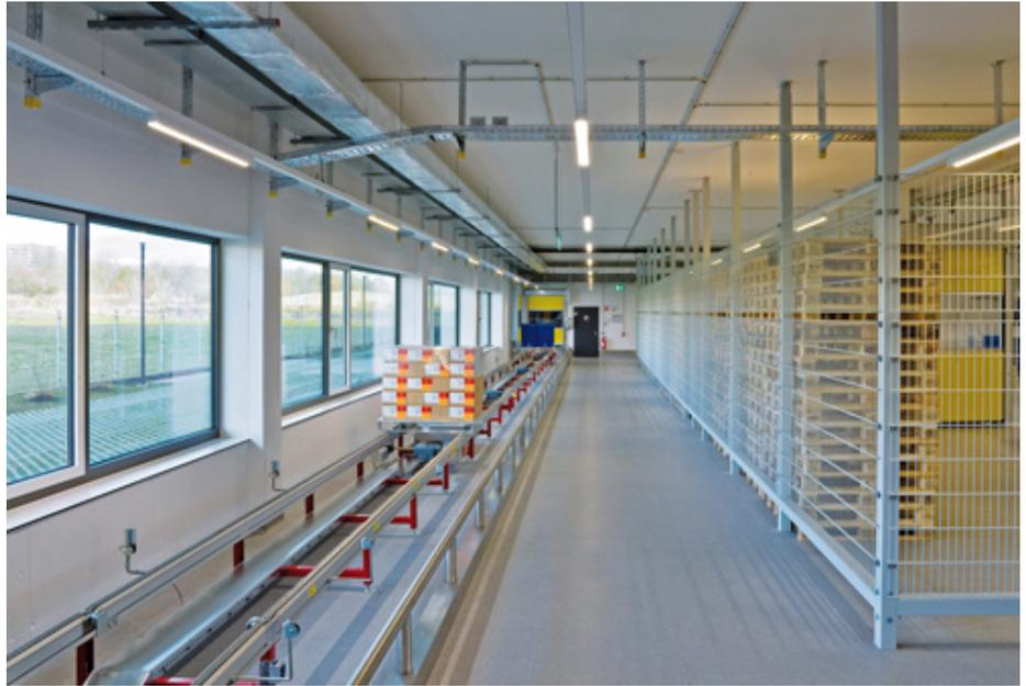
Über die im Erdgeschoss (EG) installierten Fördertechnikstrecken werden die Waren wahlweise direkt dem Hochregallager (HRL) oder zunächst dem Handlager zugeführt. (Copyright I. Scheffler)
