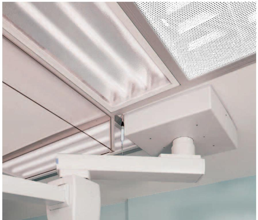
*OP-Reinluftdecke in Kombination mit Luftleitschürze aus Verbund-Sicherheits-, oder Plexiglas, Reinraum-Einbauleuchte (Schutzklasse IP 65), Umluftansaug aus lackiertem Lochblech*
