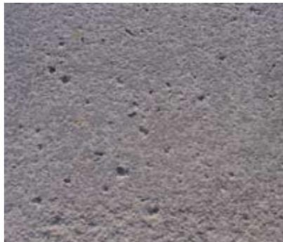
Löcher und Lunker in vorbereiteter Betonoberfläche
